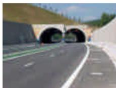
C'est ce que **LUCIOLE** a permis de réaliser sur l'A20 entre Cahors Nord et Cahors Sud pour le compte d'ASF (Autoroutes du Sud de la France). Préconisés par Scetauroute et installés par ETDE, deux systèmes **LUCIOLE** de 3 x 11 kW chacun alimentent les deux tunnels. Pilotés par un capteur de lumière, **LUCIOLE** délivre 100% de la puissance la journée pour réduire de 30% dès la tombée de la nuit.
